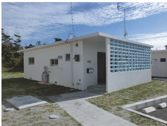
定住促進住宅(戸建て)
