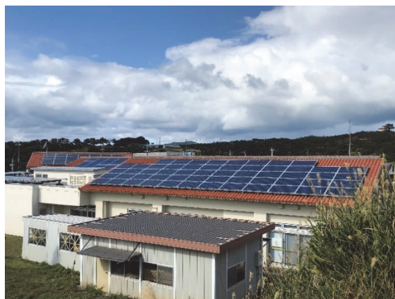
太陽光パネル
