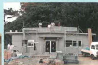
商工会会館建設風景 (青年部がボランティアで ブロック積み)
