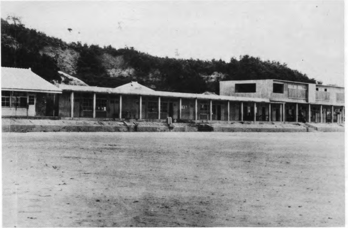
昭和33年頃の校舎「かやぶき」から鉄筋コンクリートの校舎になる
