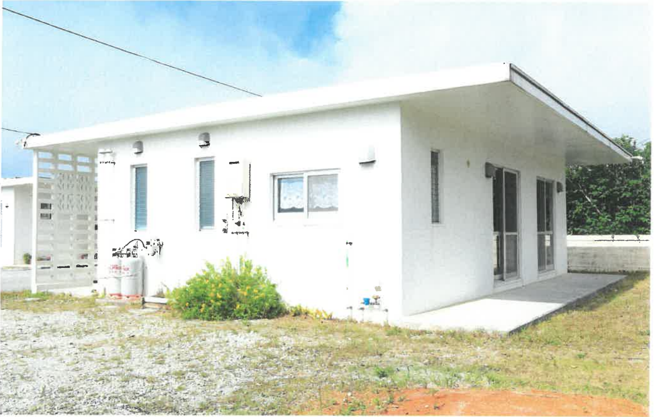
外観(敷地入口側)
